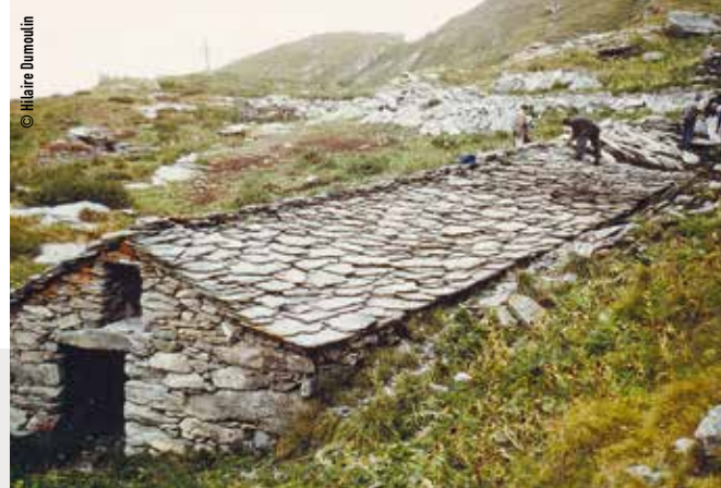
RÉNOVATION DE LA GRANDE ÉCURIE, SEPTEMBRE 1981.
