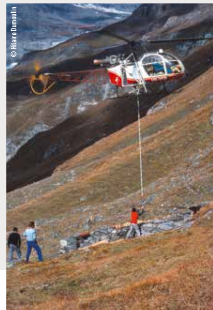
TRAVAUX DE RÉNOVATION DE L'ÎTRE DES FONTÂNES, 1988.
