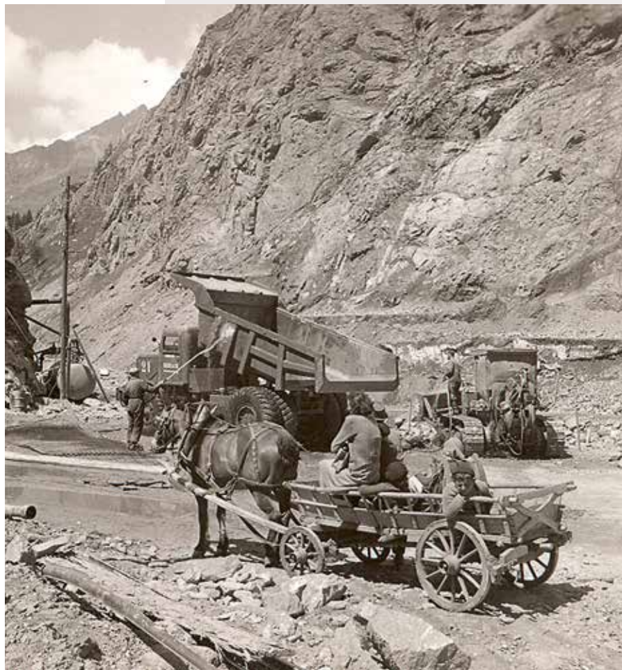
CONSTRUCTION DU BARRAGE DE MAUVOISIN, ÉTÉ 1952. (COLL. FORCES MOTRICES DE MAUVOISIN)
